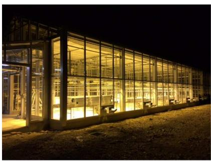
✓ Construction d'une serre d'expérimentation. L'enveloppe en double vitrage couvre l'intégralité de la serre.
