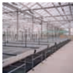
Portique implanté sur béton
