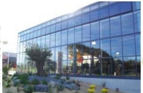
Eco Klima. L'acier utilisé pour la structure des serres est recyclé tout comme l'aluminium pour la structure d'intégration des vitrages et le verre qui les constitue. Il en va de même pour tous les joints d'étanchéité.
